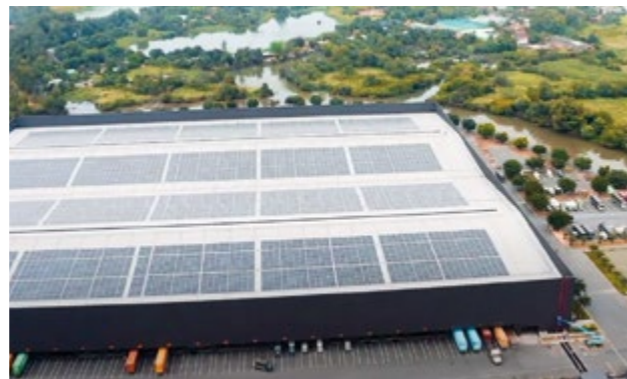
Panneaux photovoltaïques installés sur site par TBS au Vietnam.
